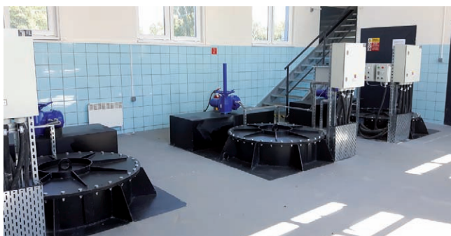
Strojovňa čerpaciej stanice
