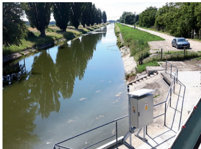
Pohľad na kanál, vstup do prečerpávacej stanice
