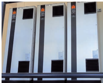
Tri frekvenčné meniče Danfoss VLT® AQUA Drive FC 202, každý s výkonom 250 kW
